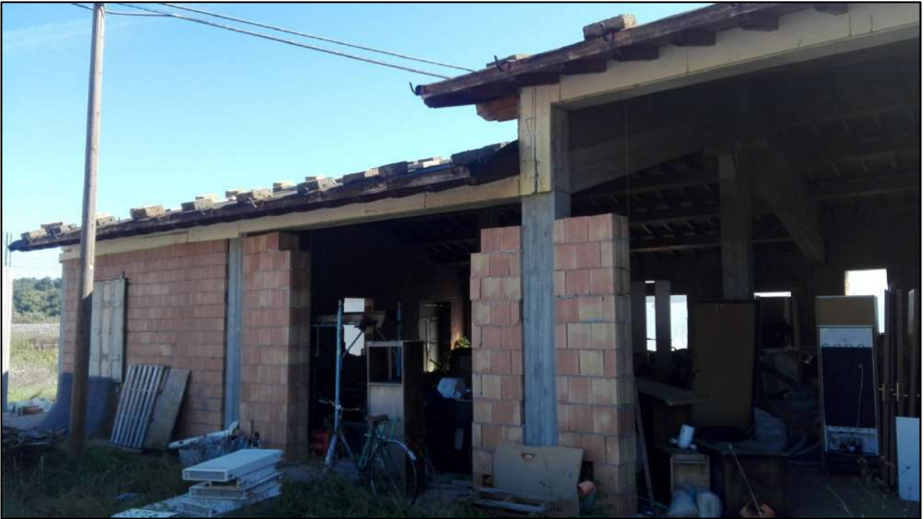
Foto: 5 (Vista Nord Ovest del fabbricato in costruzione)
