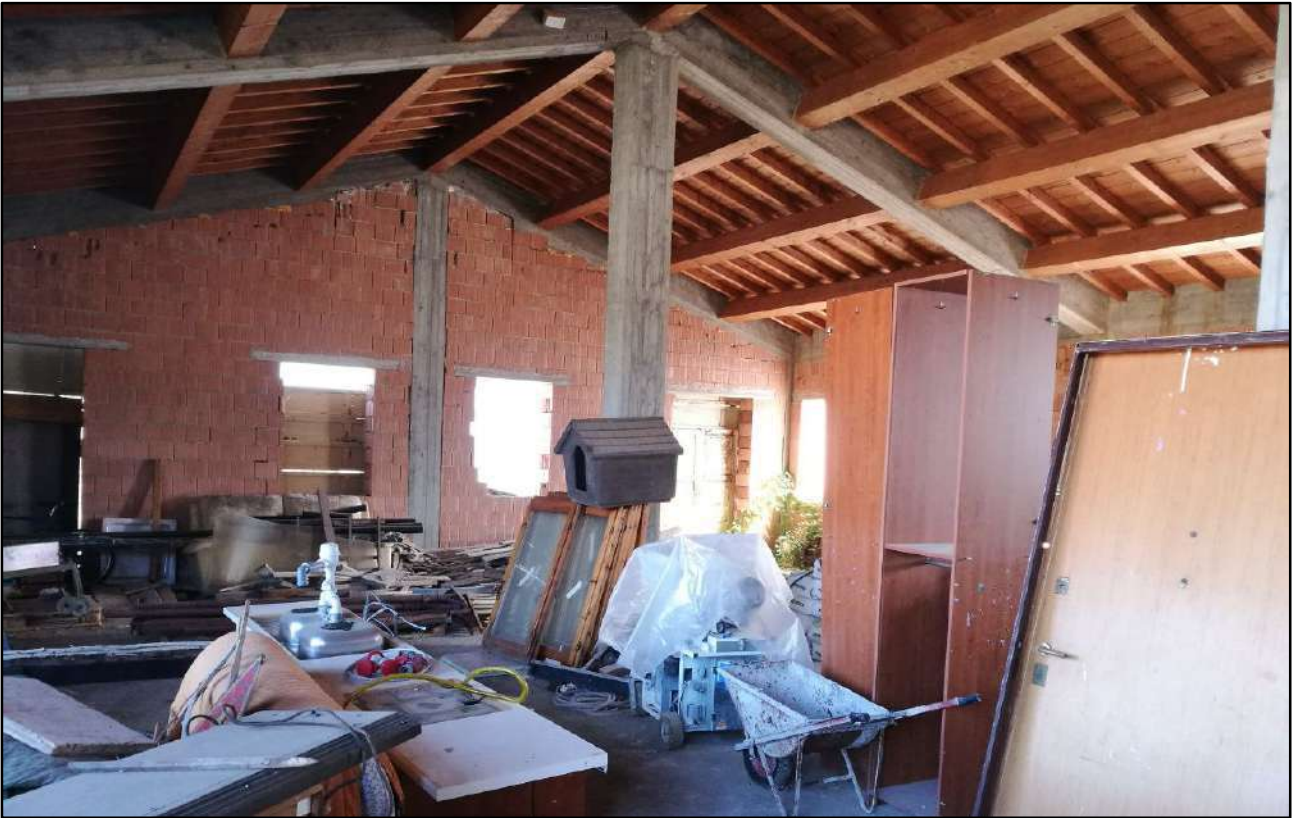
Foto: 10 (Interno del fabbricato)
