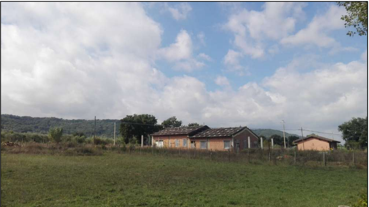
Foto: 2 (Vista Prospettica del fabbricato in costruzione)
