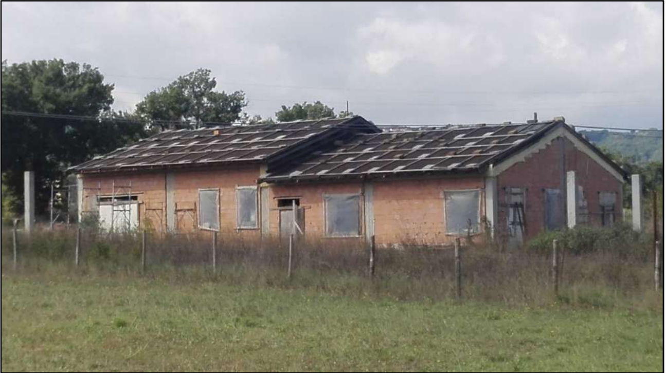
Foto: 1 (Vista prospettica del fabbricato in costruzione)
