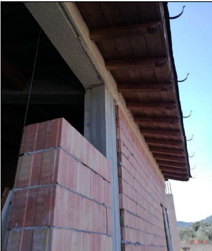
Foto: 8 (Dettaglio della gronda in legno)
