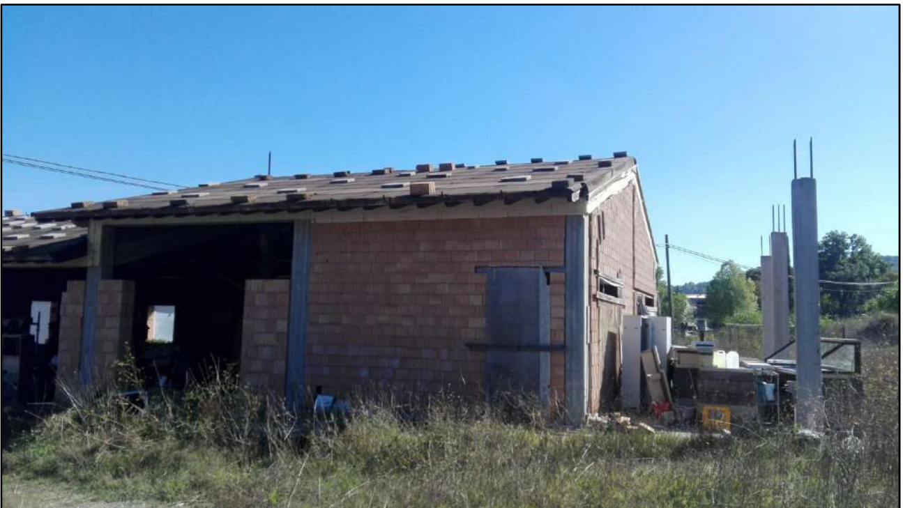
Foto: 4 (Particolare del portico sul retro della costruzione)
