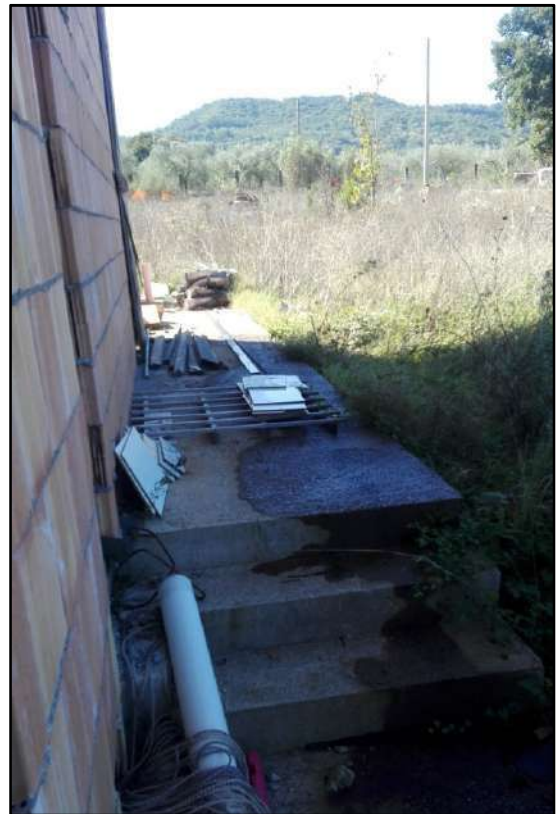
Foto: 9 (Dettaglio marciapiede esterno)
