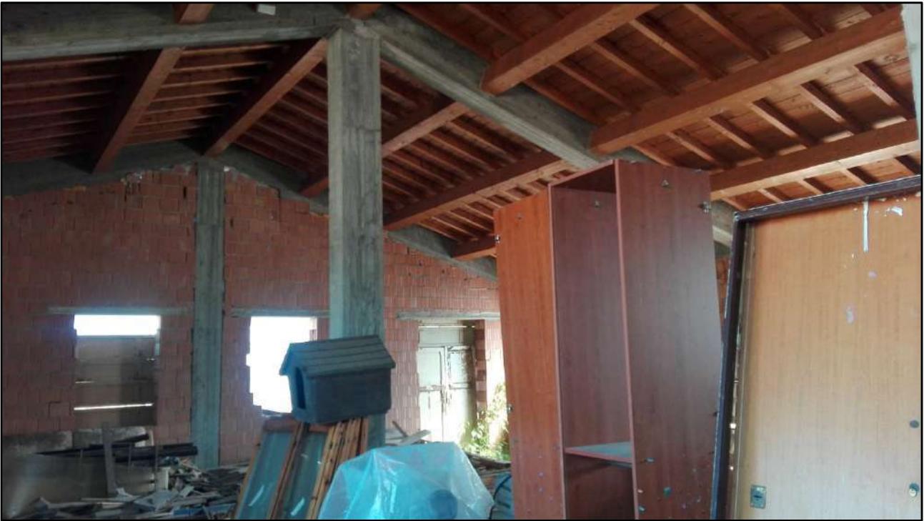
Foto: 12 (Struttura in cemento armato)
