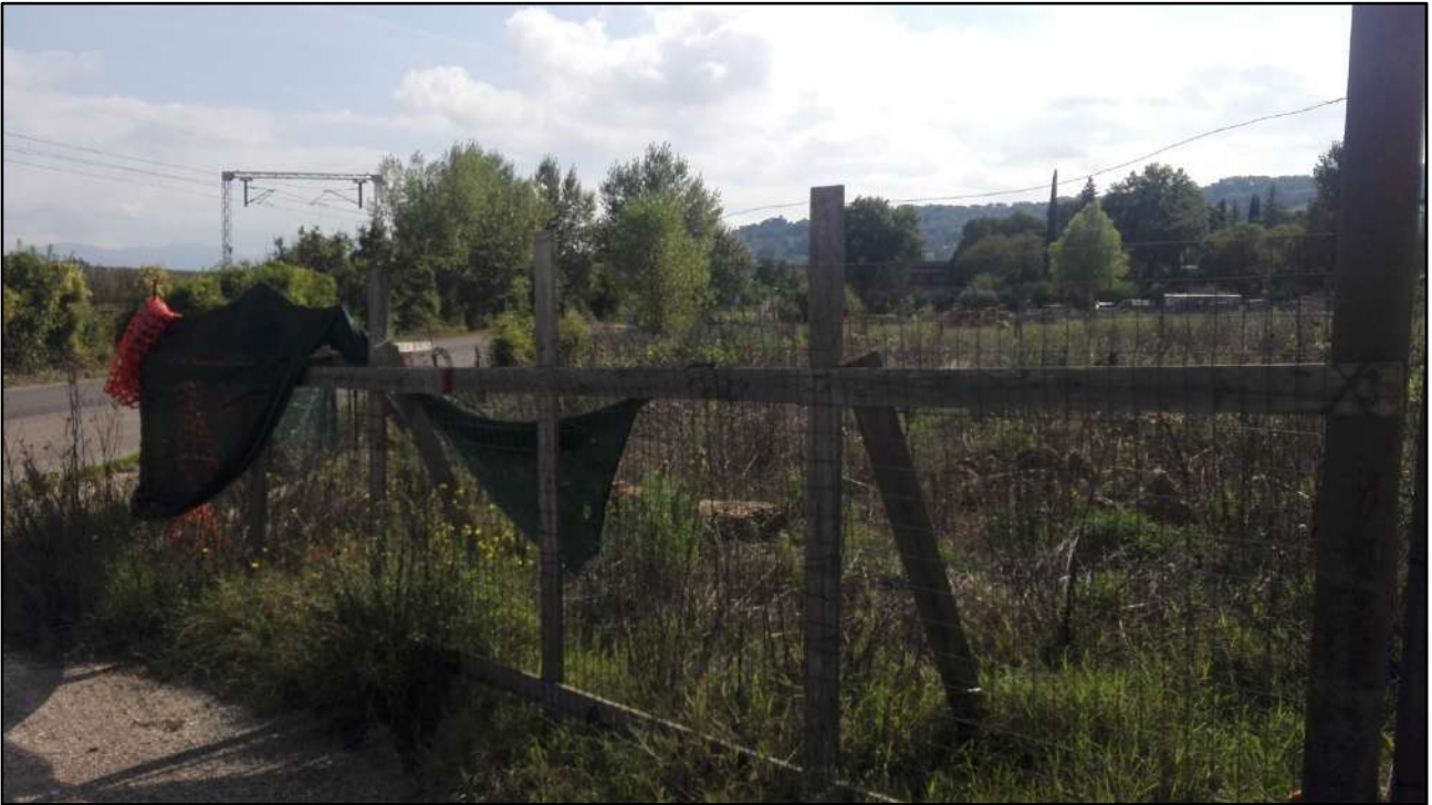
Foto: 20 (Recinzione adiacente il cancello di ingresso)
