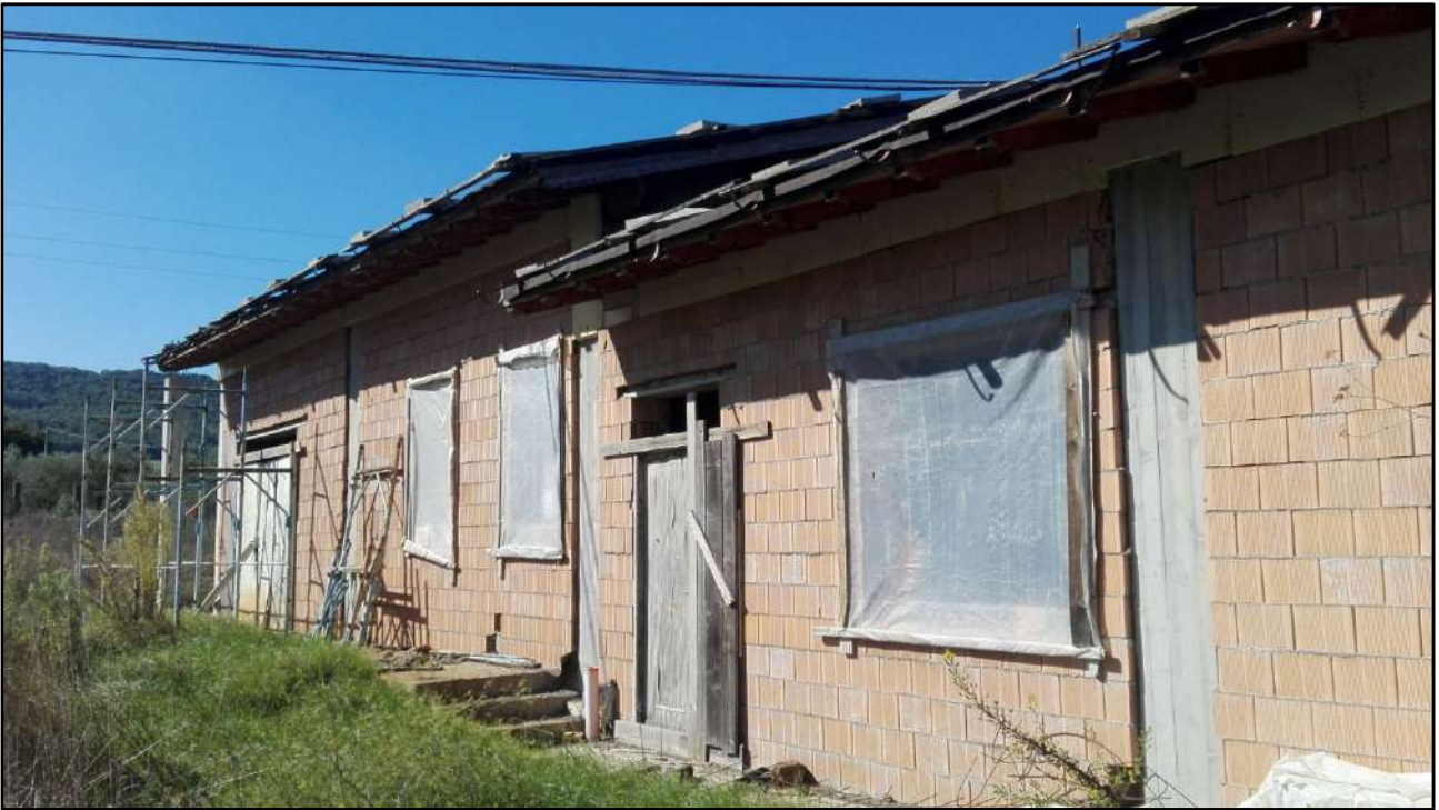
Foto: 7 (Vista Sud Est del fabbricato in costruzione)
