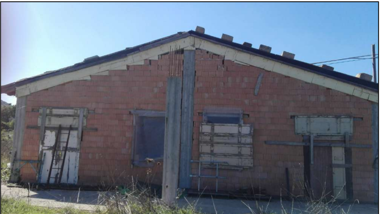
Foto: 6 (Vista Nord Est del fabbricato in costruzione)
