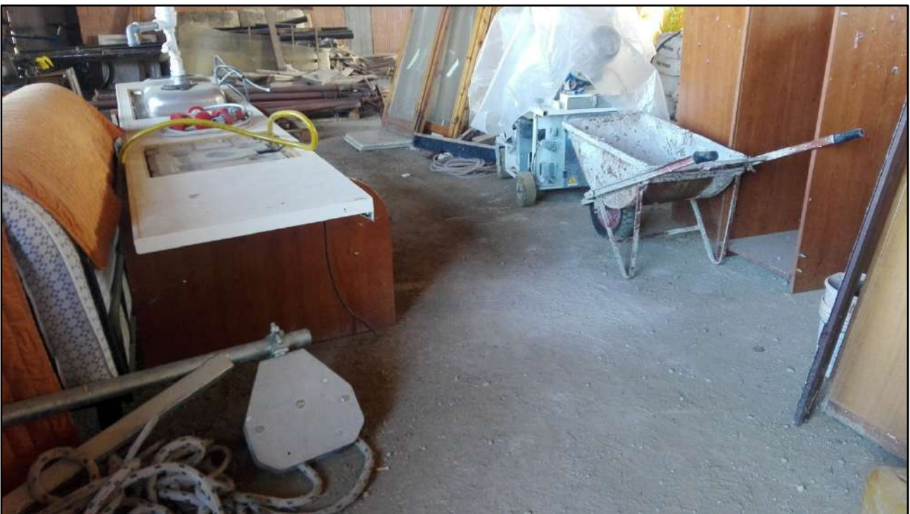
Foto: 13 (Dettaglio della pavimentazione allo stato grezzo)
